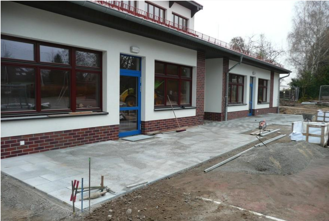
Die Terrassen vor den Horträumen des Mehrzweckgebäudes sind mit Granitplatten befestigt. (Foto kurz vor Fertigstellung des 1. Bauabschnittes, November 2013,. © D. Schubert)
