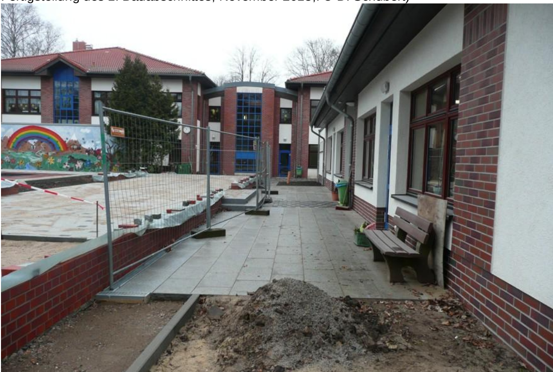
Im 2. Bauabschnitt ist nach dem Bau der Klinkermauern die höhenmäßige Untergliederung in 2 Ebenen erkennbar. Flache Treppen verbinden die beiden Ebenen. Durch diesen Höhenversatz verläuft nun das Oberflächengefälle und damit auch das Regenwasser nicht mehr in Richtung der Gebäude (Foto November 2014. © D. Schubert ).
